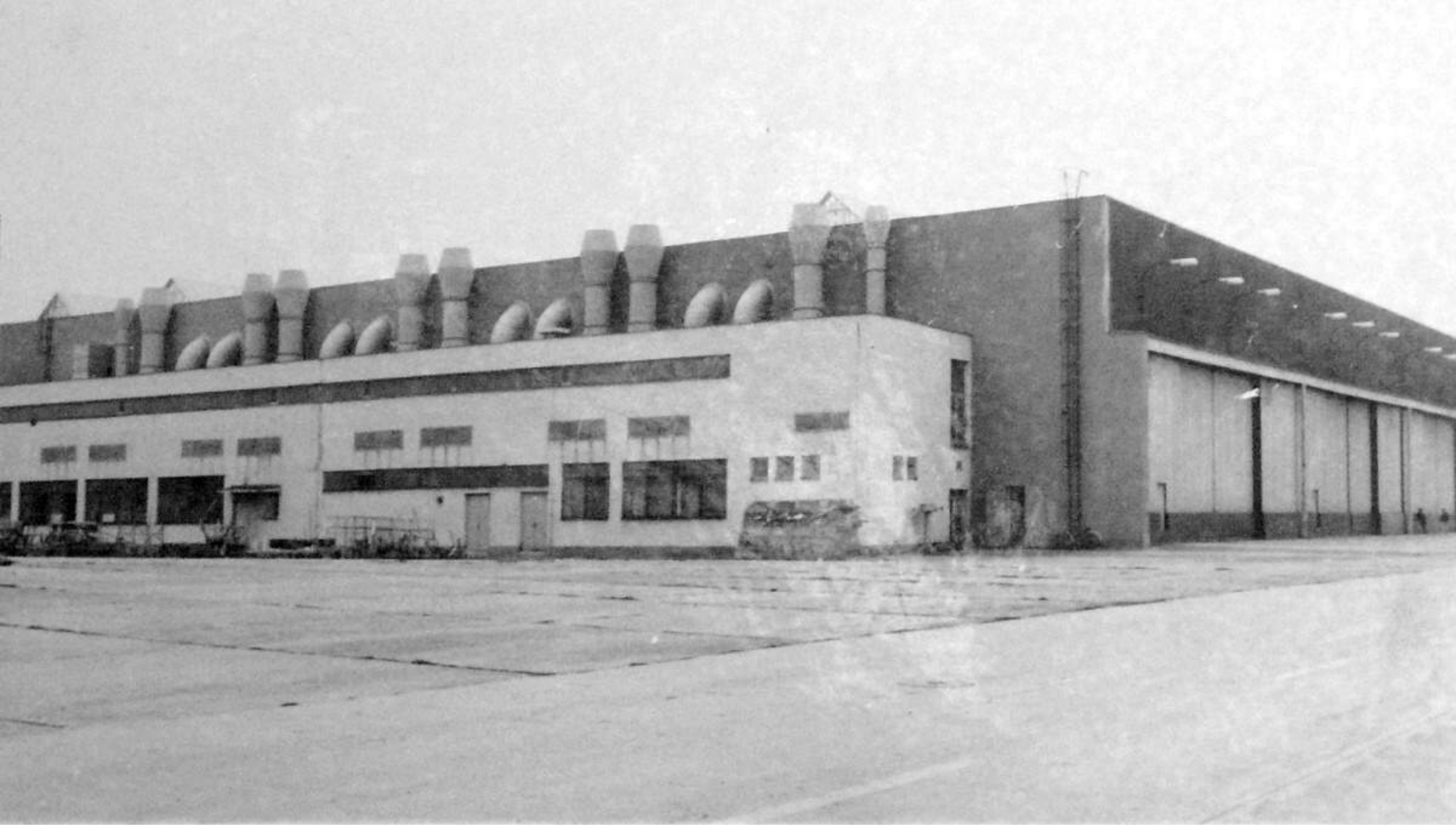
МОНТАЖНО - ОМОНГОЛСОНСКО НАЛА УУБНДОНСОНА В РОКУ 1986
