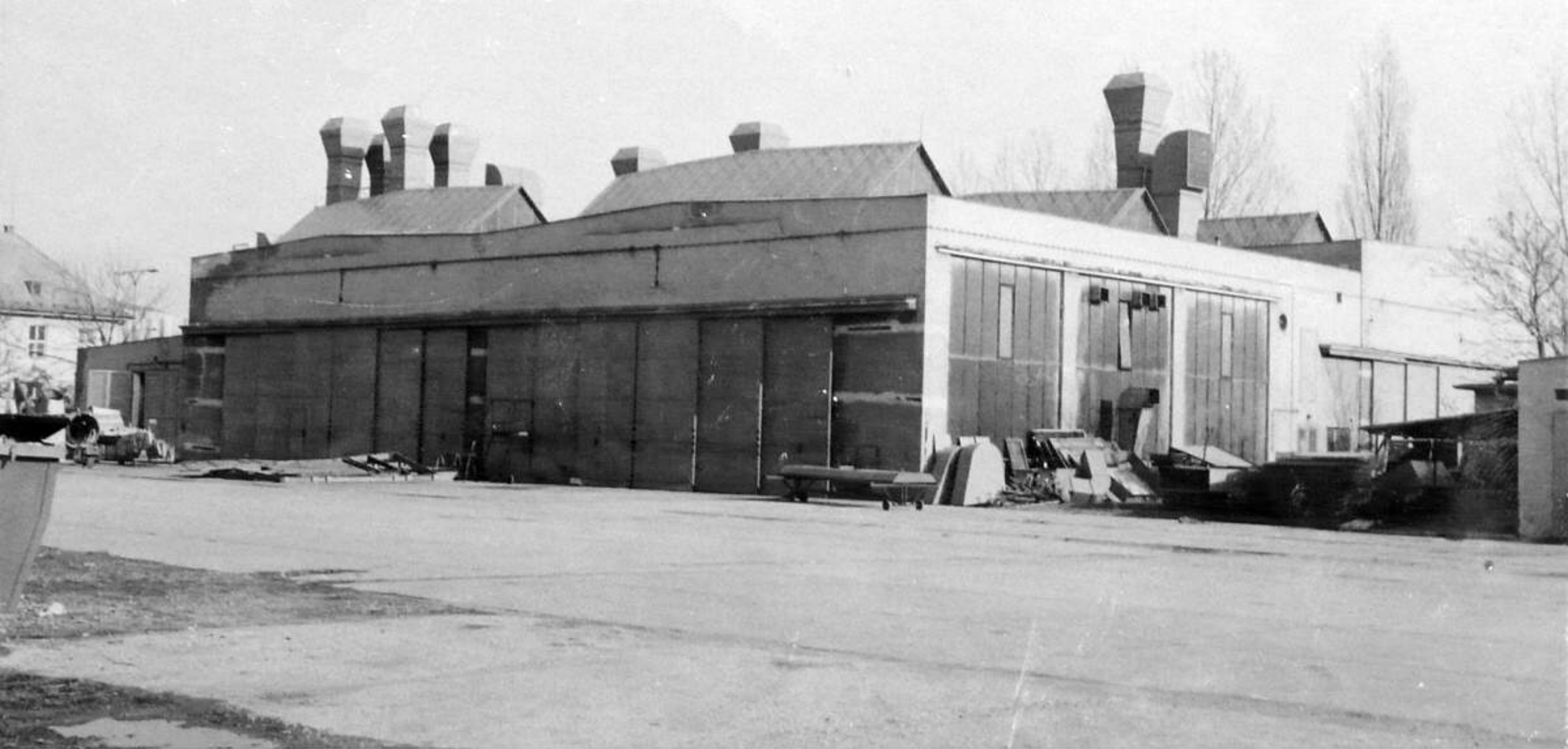
výrobná hala ke demontáži, ukrytí a káteru vybudovali v r. 1966
